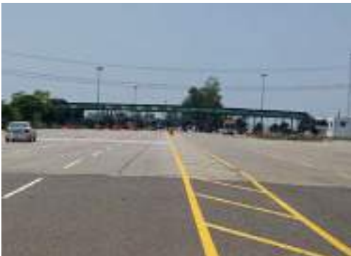
Maigalganj Toll Plaza
